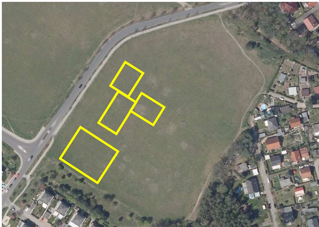
Bild 6: Luftbildausschnitt (Quelle BRANDENBUR VIEWERPLUS /U.11/) aus einer Überflieger vom Mai 2021 mit etwaiger Markierung der geplanten Neubaugrundrisse
